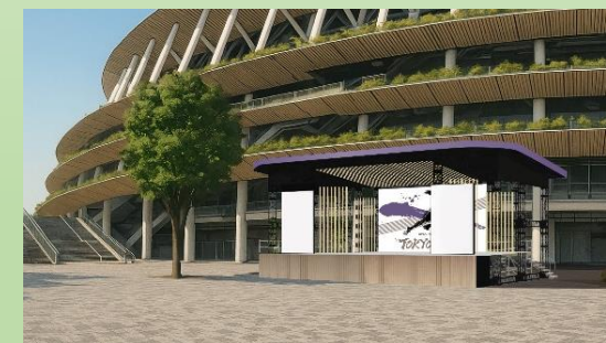
▲国立競技場の外に特設ステージ (メダルプラザ)を設置予定
