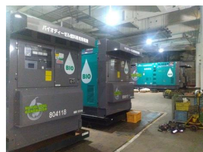
バイオ燃料を使用した仮設発電機
