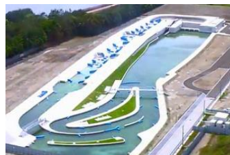
カヌー・スラロームセンター
