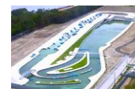
カヌー・スラロームセンター
