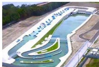
カヌー・スラロームセンター
