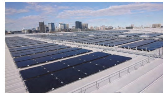
東京アクアティクスセンターに設置された太陽光発電パネル
