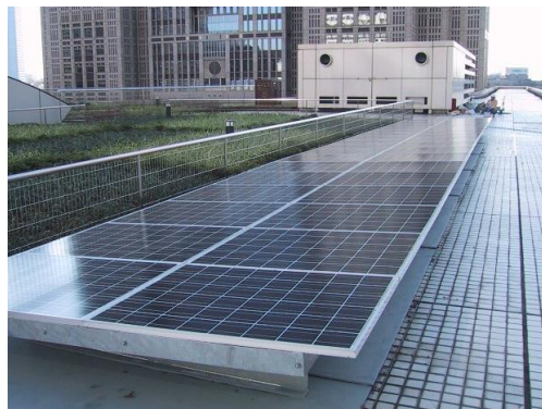
太陽光発電パネルの例
